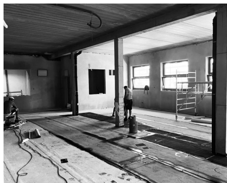
Výstavba jídelny je v plném proudu.
