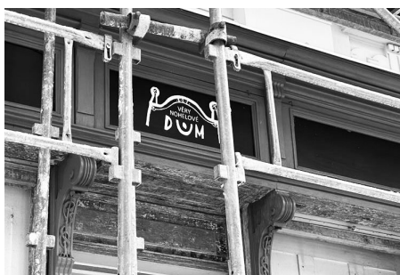
Opravy se dočkala fasáda domu po paní Nohelové.
