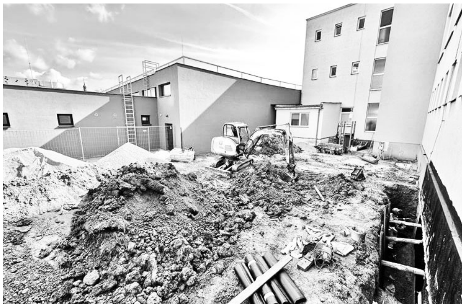
Stavební práce chod školy nenarušují.
