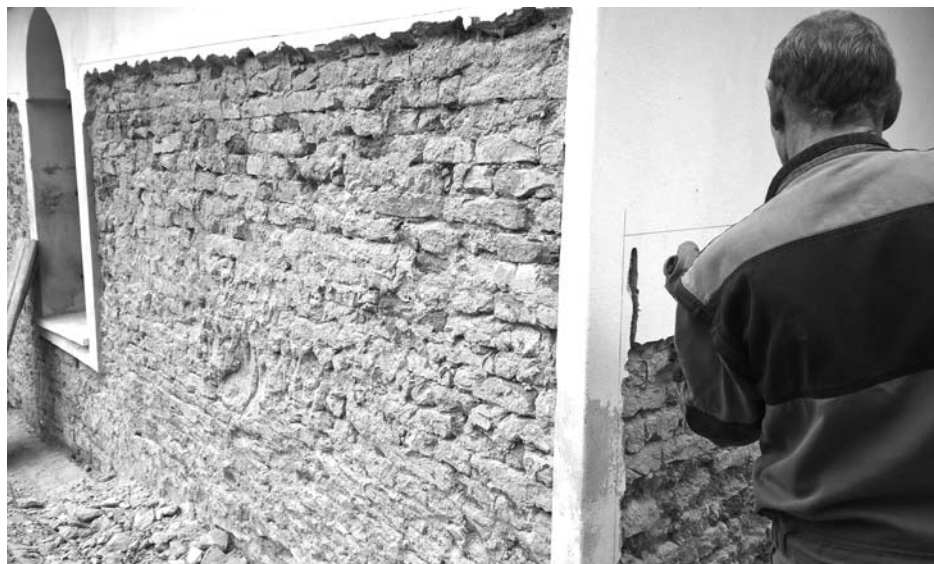
Pracovníci městských služeb na přelomu února a března oklepávali omítku ze hřbitovní kaple.
