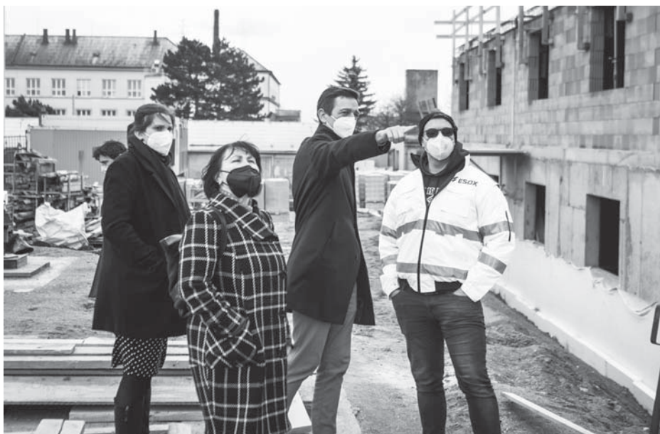
Hejtman zavítal i na stavbu domova pro seniory.
