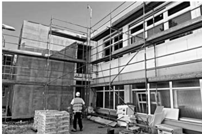
Pracovalo se i na MŠ Na Sídlišti.
