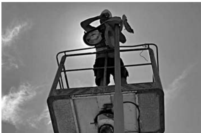
Pěči získalo i veřejné osvětlení ve městě.
