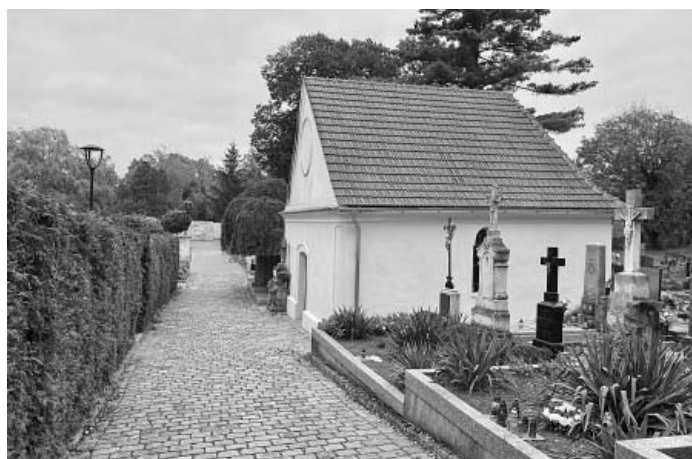
Byla zrenovována hřbitovní kaple.
