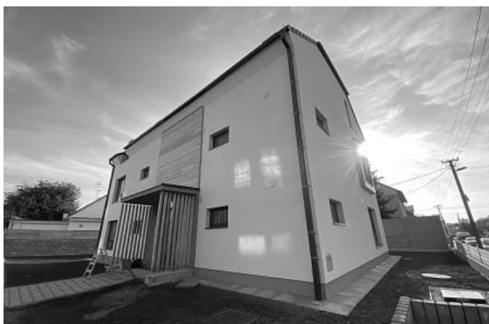
Byty v Žižkově ulici se kolaudovaly v září 2020.
