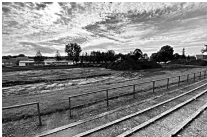
Započaly práce na městském stadionu.
