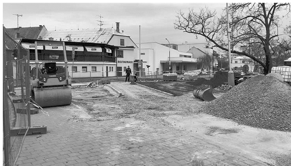
Stavební práce na cyklostezce u COOPu začaly v únoru.
