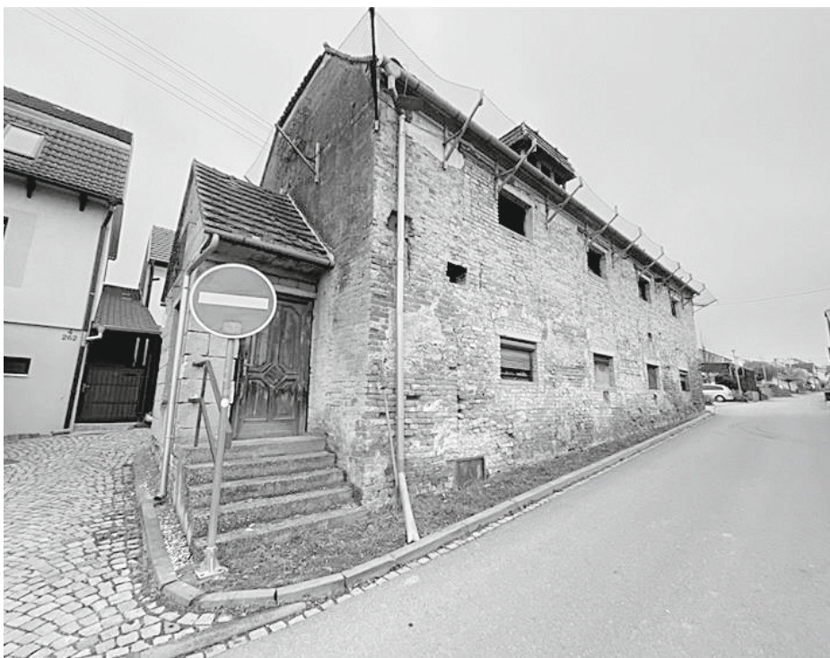
Současný stav budovy.
