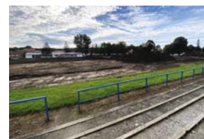
30. července 2020 Zahájení rekonstrukce stadionu
