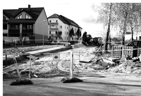
V říjnu se začala budovat dlouho očekávaná komunikace, která propojí ulici Gen. Peřiny a Údolní.
