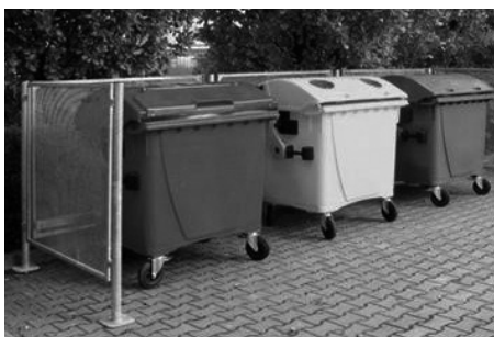
Kovová konstrukce pro kontejnerové místo v ulici Generála Peřiny ochrání zaparkovaná auta.
