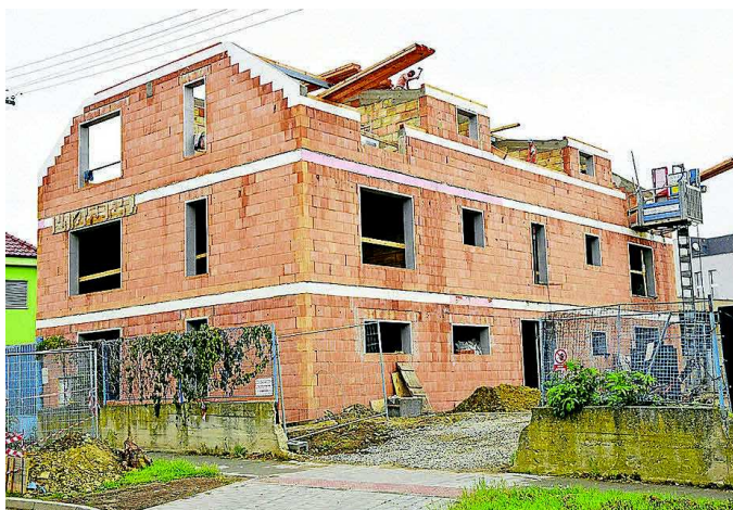
Výstavba podporovaného sociálního bydlení pro seniory. Foto: Jana Hrádková
