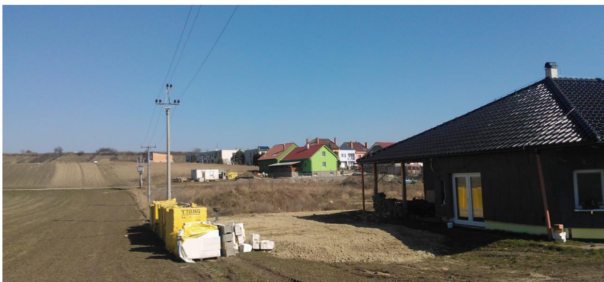
Pohled od jihozápadu na okraj řešeného území. Stávající dům vpravo leží mimo řešené území. El. vedení vzdušné vede po hranici řešeného území.
