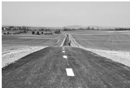
Na cyklostezce už se jezdí.
