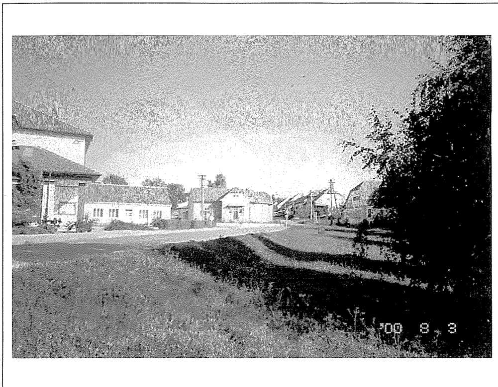
3. Pohled z ulice A.Šebestové na Obecní úřad.
