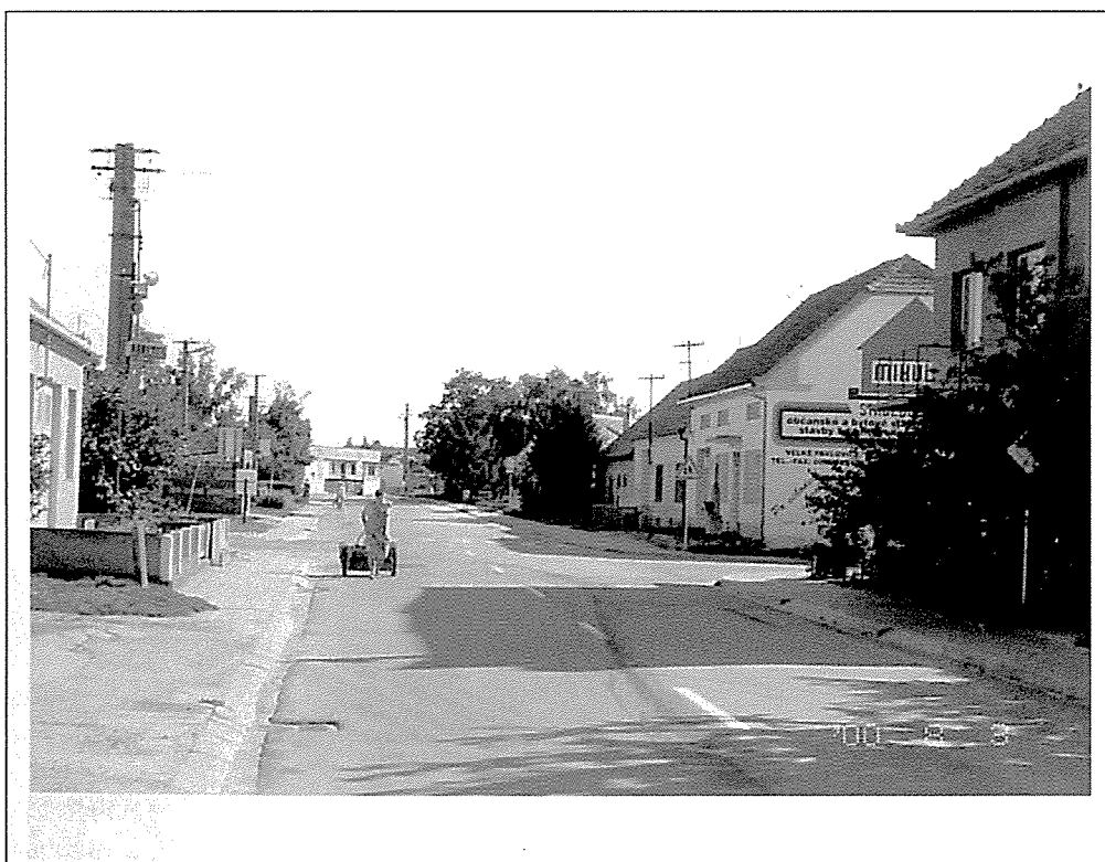
4. Pohled do centra obce na nákupní středisko. Obcí prochází státní silnice II/421
