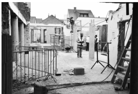
Práce v budově kina jsou v plném proudu
