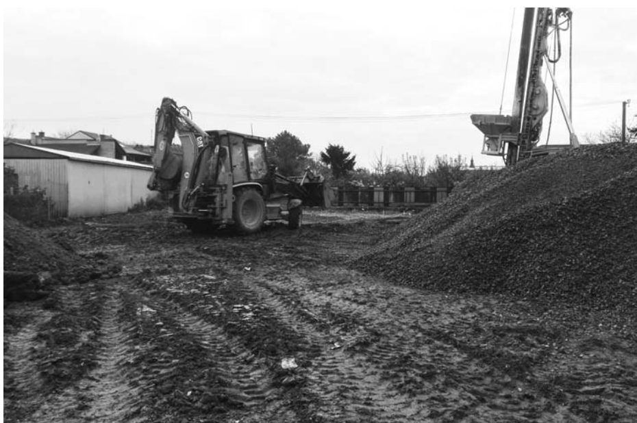
Nestabilní podloží zpevní 210 pilířů.
