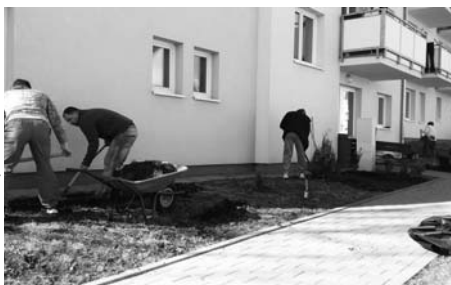
Úpravy pozemku kolem bytového domu.
