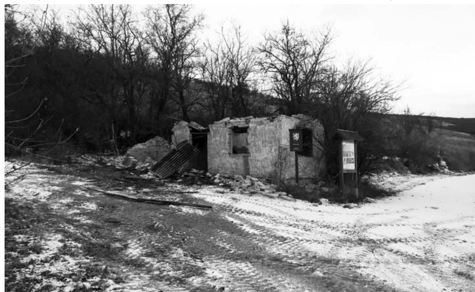
Nebezpečný objekt před zbouráním.
